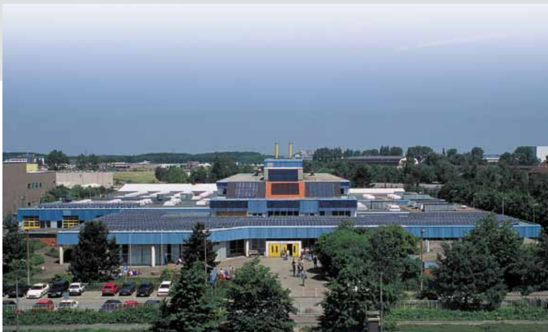
Centre de formation Butzweilerhof de la Chambre des Métiers de Cologne
