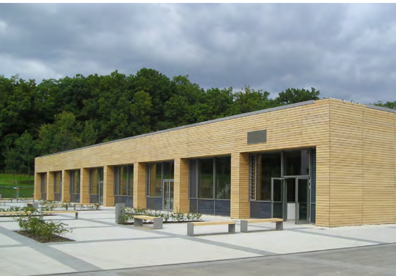
Die neuen Werkstatt- und Laborräume
