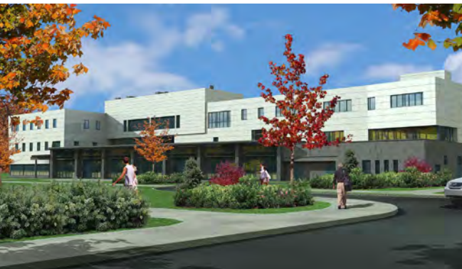
Das neue Gebäude des Technology-Departments
